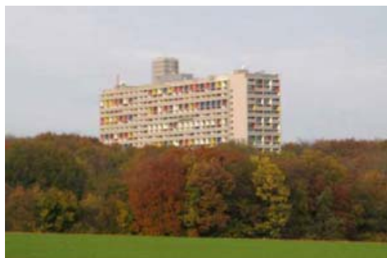
Vue d'ensemble de la Cité Radieuse Le Corbusier de Briey-en-forêt
